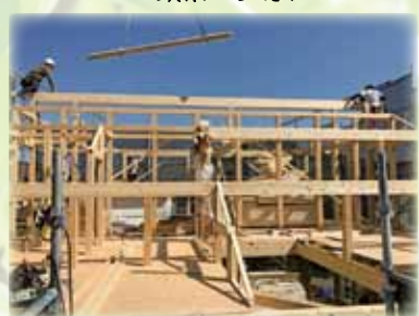
晴天に恵まれ棟上げ完了！
