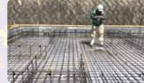
網目状に鉄筋が組んである所にコンクリートを流し込んでいくんです。昔はありませんでしたが、今の基礎は、網目状に鉄筋を組んだ
