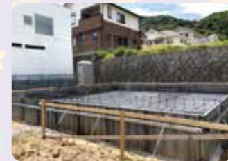
網目状に鉄筋が組んである所にコンクリートを流し込んでいくんです。昔はありませんでしたが、今の基礎は、網目状に鉄筋を組んだ
